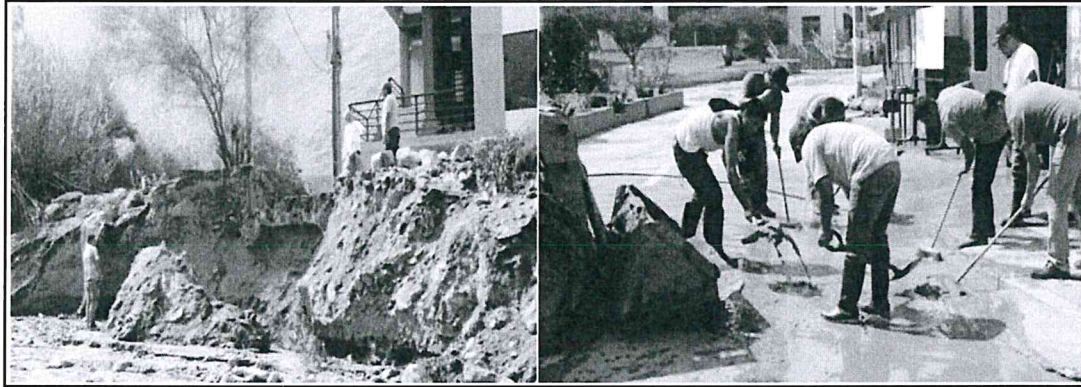
Figura N° 04: Fotos de los daños causado por huaicos el 2017
